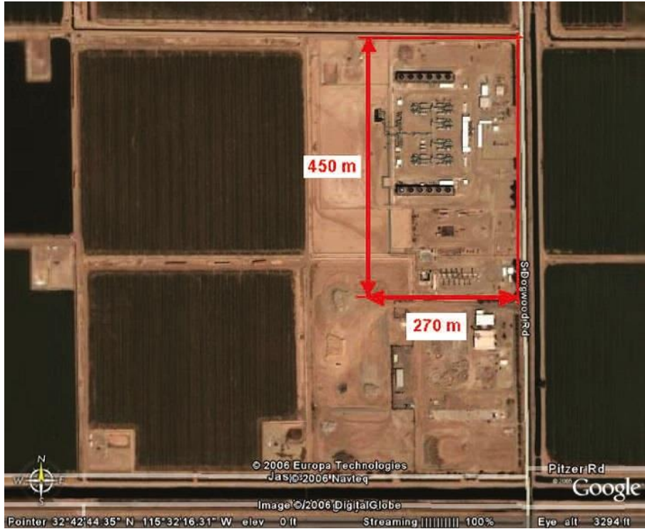
Şekil 4 Kaliforniya Heber SIGC ikili santrali uydu görüntüsü (Google Earth 2006).
